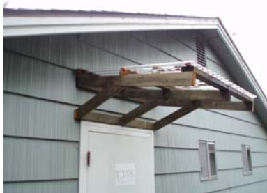
Awning over left rear door
